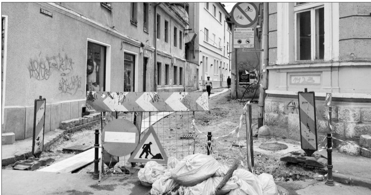
Strada Valentin Wagner din Centrul istoric este în curs de reabilitare
