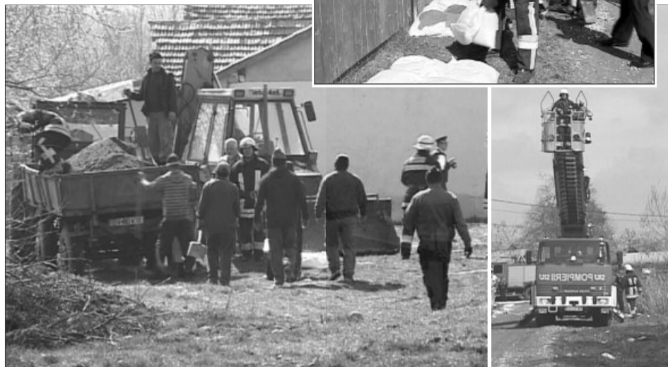
Localnicii au învățat cum să facă baraje din saci de nisip pentru a se proteja de ape
