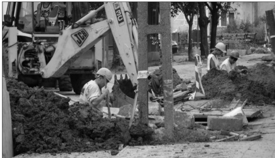
Bulevardul Griviței se află în șantier de la începutul lunii august
