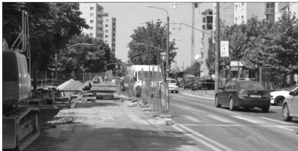
Lucrările de asfaltare ar trebui să se termine înainte de venirea gerului
