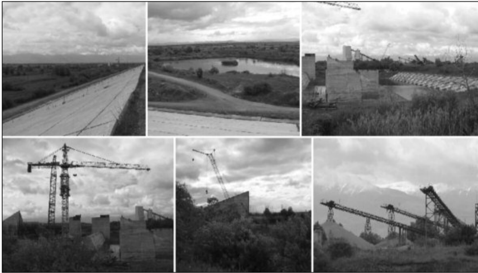
În perioada 1988-2012, statul a investit la Mândra aprox. 110 mil. de euro, însă acum, șantierul este în conservare
