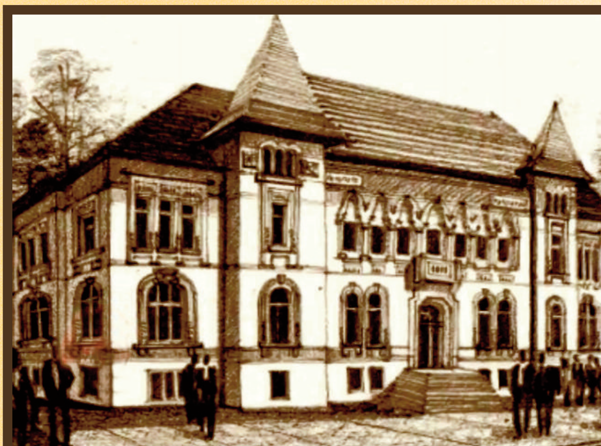
Camera de comerț din Brașov (acum, Biblioteca „George Barițiu”)
