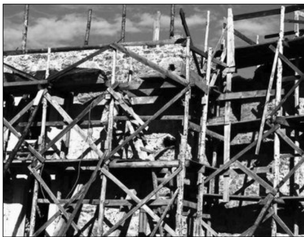
Lucrările de reabilitare sunt în plină desfășurare
